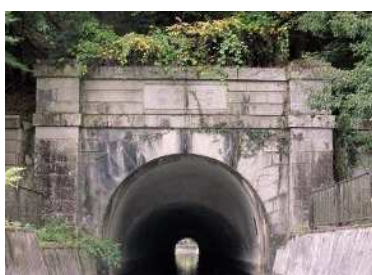
第二隧道（東口）
