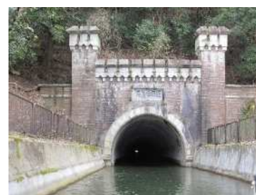
第三隧道（東口）
