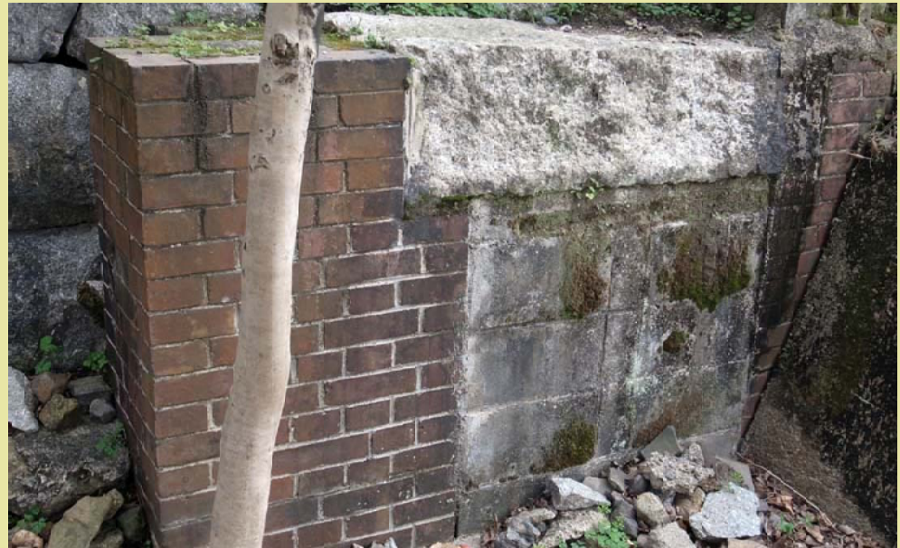
【線路下にあったトンネルの煉瓦壁面の一部】
