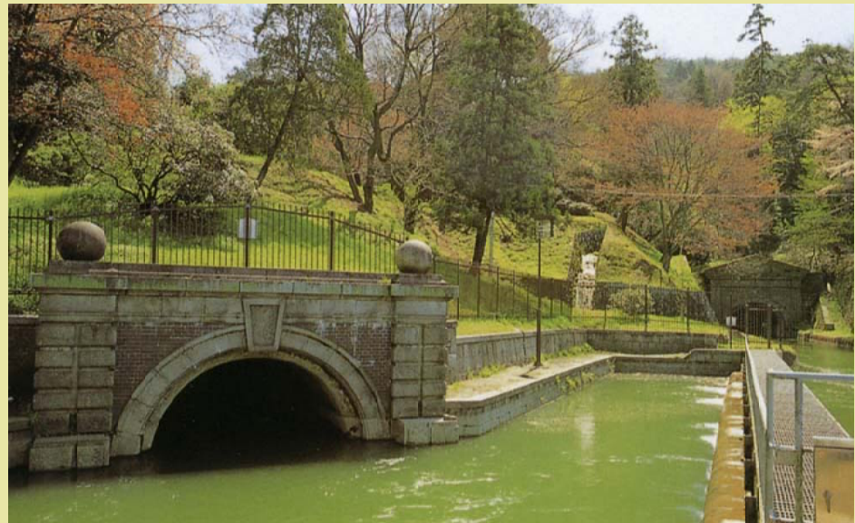
【蹴上にある第1・第2疏水の合流点 左側が第2疏水の出口】
