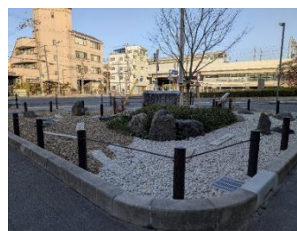
京都の作庭技術を活かした雨庭整備
