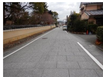
石畳風アスファルト舗装後
