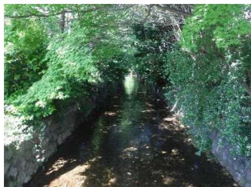
整備前 (六軒橋下流)
