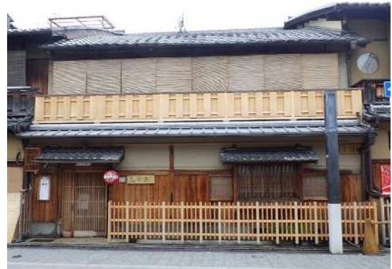
修理・修景後
