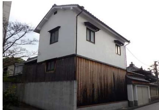
修理・修景後
