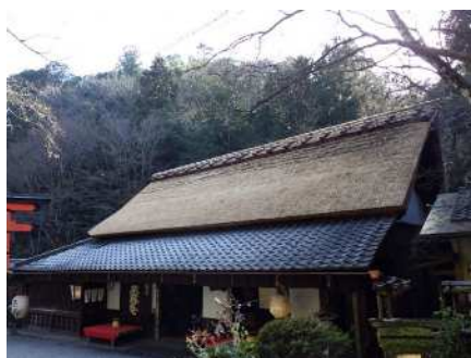
修理後 (屋根修理)
