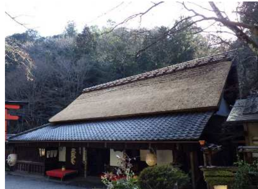
修理・修景後
