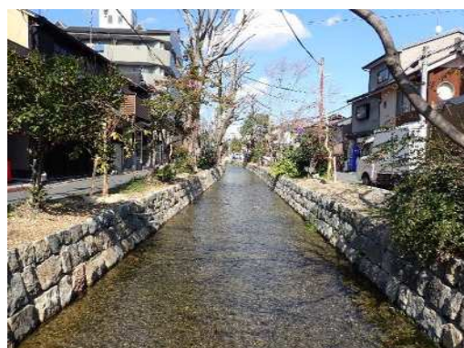
整備後 (六軒橋下流)
