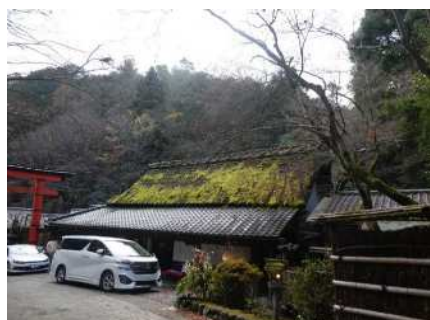
修理前 (屋根修理)
