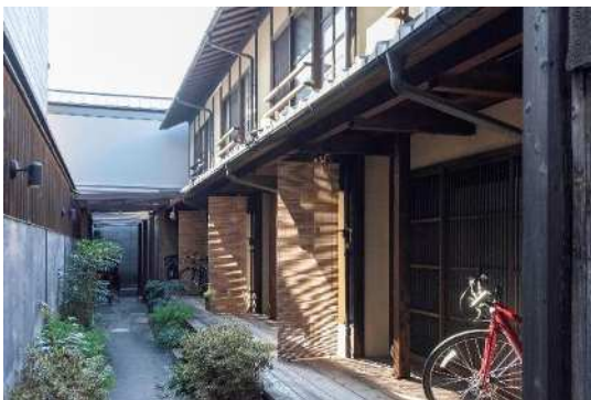
改修後の長屋
