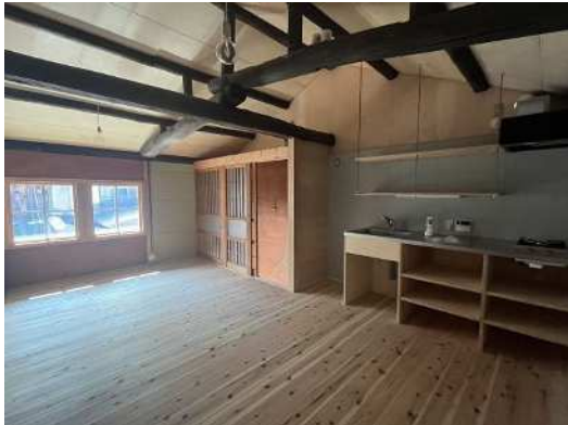
改修後の室内
