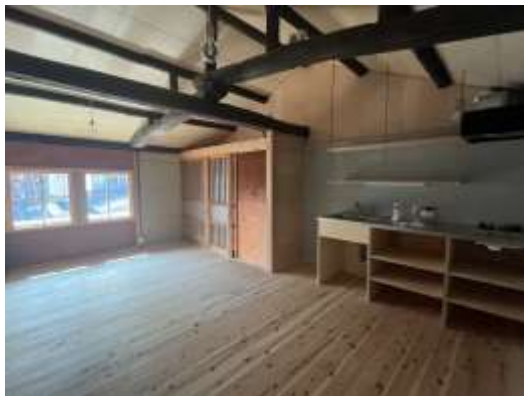
改修後の室内
