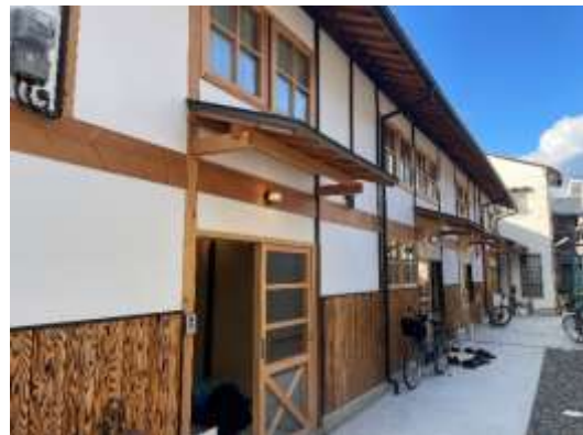
改修後の外観
