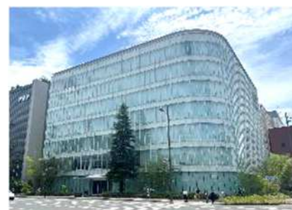
元ワコール新京都ビル 飛島建設
