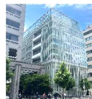
オムロン京都センター ビル啓真館 株式会社竹中工務店
