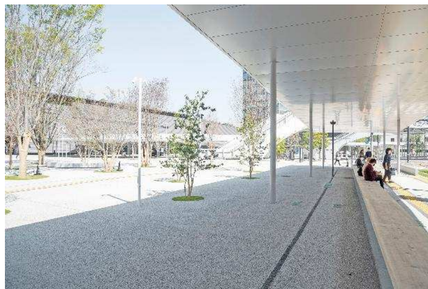
熊本駅・駅前広場
