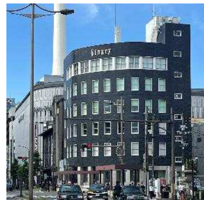
旧東京生命保険京都支社 安井武雄建築事務所
