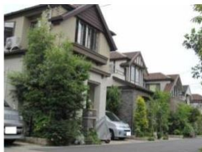
戸建街区（レベル2）
