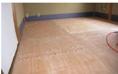
2階床組の構造用合板の設置
