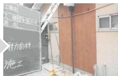
構造用合板の設置
