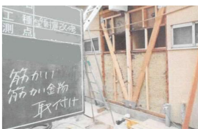
筋交い、金物の設置
