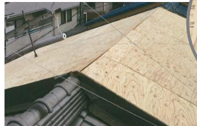
屋根面の構造用合板の設置
