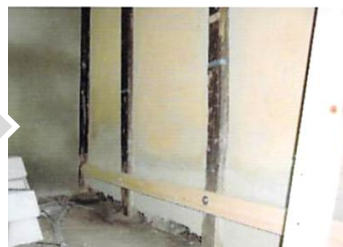
根がらみの設置
