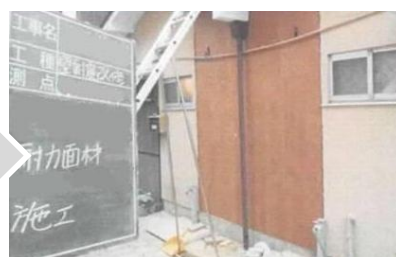
構造用合板の設置
