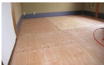
2階床組の構造用合板の設置
