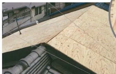
屋根面の構造用合板の設置
