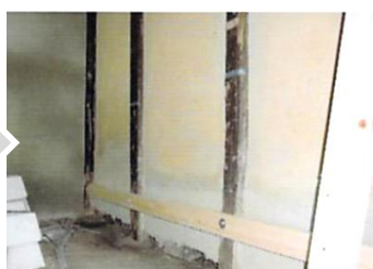
根がらみの設置
