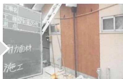
構造用合板の設置
