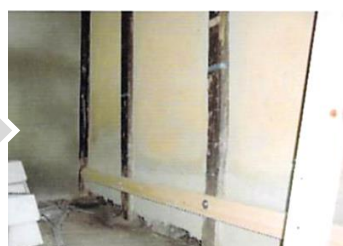
根がらみの設置
