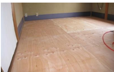
2階床組の構造用合板の設置
