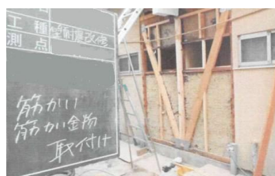
筋交い、金物の設置
