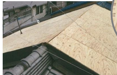
屋根面の構造用合板の設置
