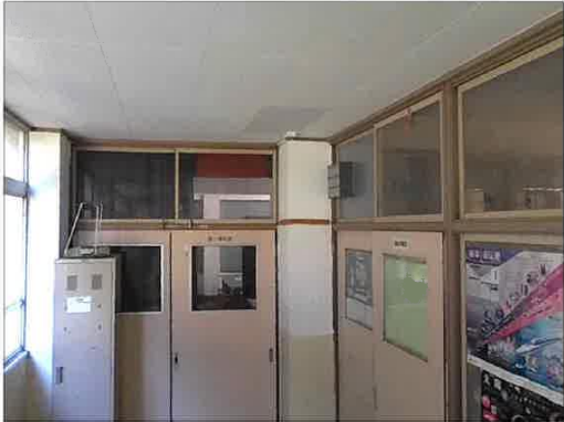
【写真3】換気を廊下に直接排出
