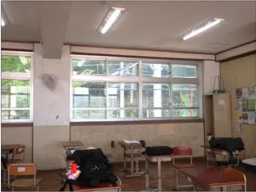
【写真4】内装制限 2階教室（3－6）
