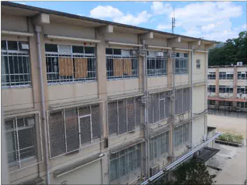
【写真6】代替進入口部 4階格子
