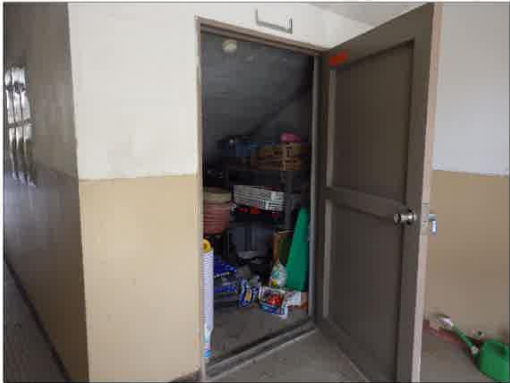
【写真5】階段下物入の扉
