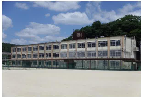
① ⑫北校舎棟一南面
