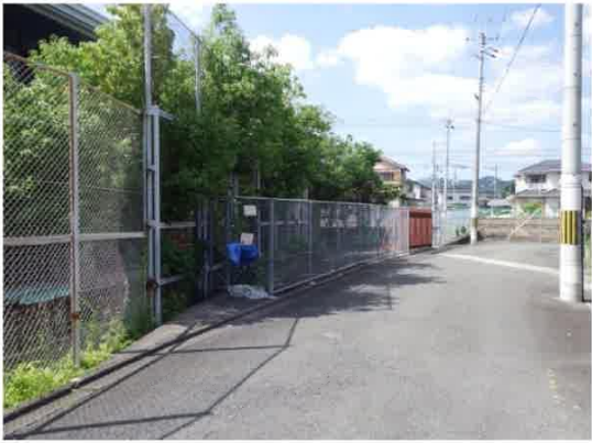
⑰ 道路境界囲障（東面）
