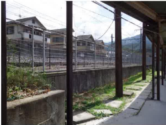
⑮ 敷地境界塀（東側北面）
