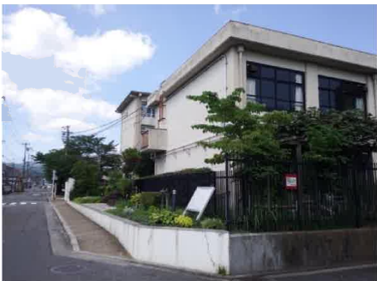
㉘ 敷地境界囲障（南側西面）
