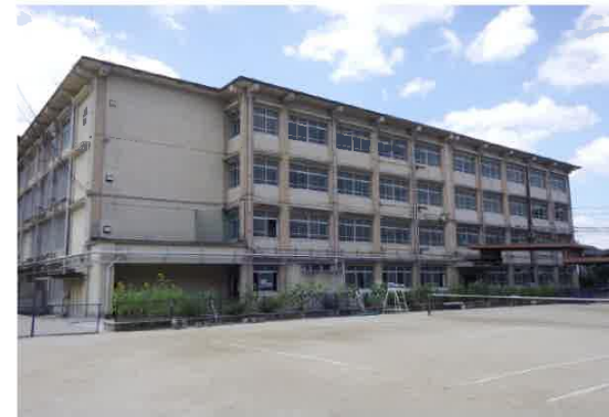
④ ②〇本館棟一北面
