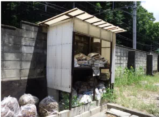
⑦ ゴミ置場3
