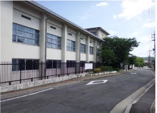
④ 道路境界囲障（北側西面）
