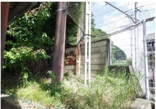
⑭ 敷地境界塀（北面）
