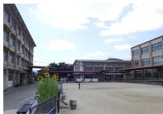
⑧ 渡り廊下2—南東面
