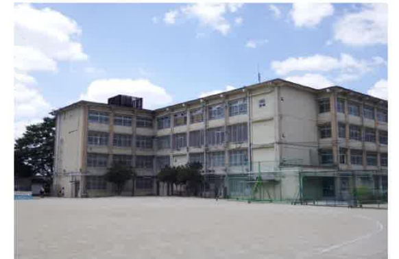
⑤ ⑮本館棟一北東面
