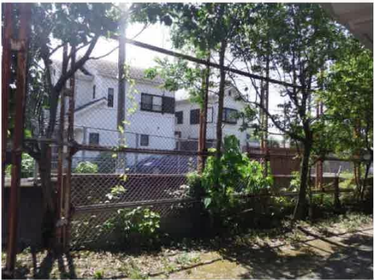
⑯ 道路境界囲障（北側東面）
