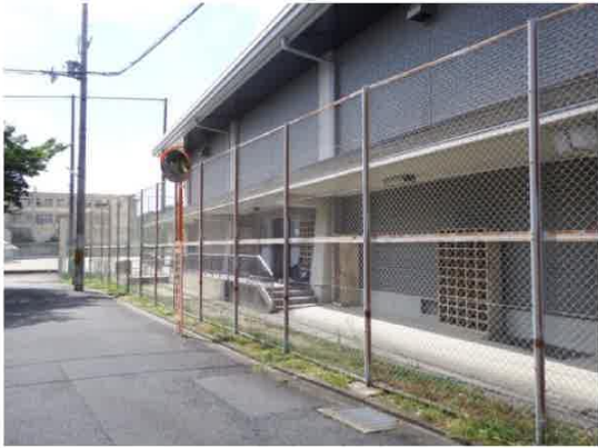
⑲ 道路境界囲障（東側南面）
