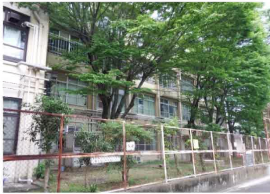
㉕ 敷地境界囲障（南面）
