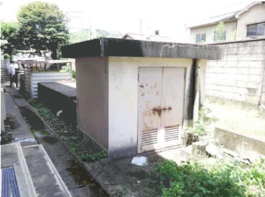
⑩ ポンプ室
