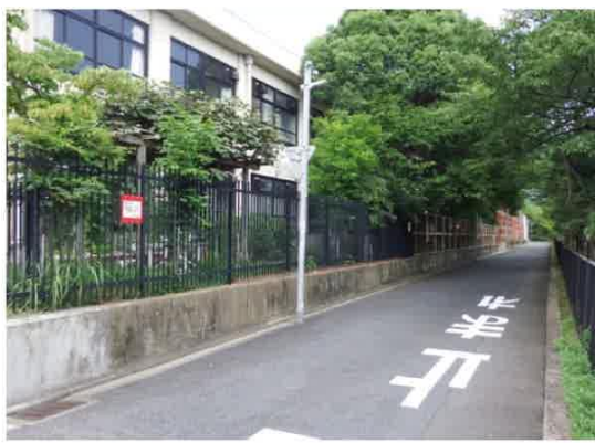
㉗ 敷地境界囲障（西側南面）
