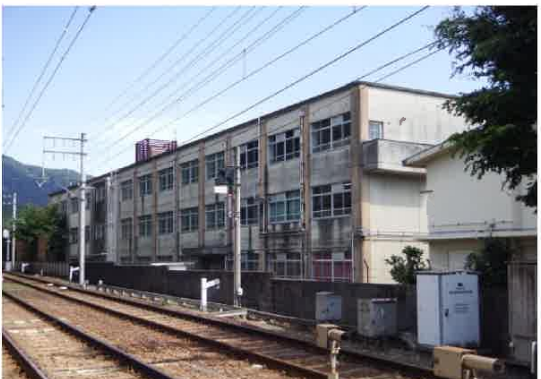
⑦ 敷地境界塀（北面）
