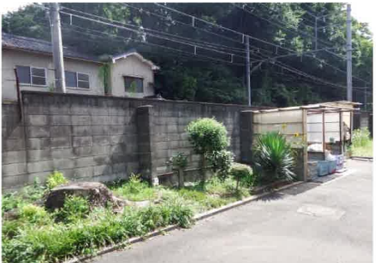
⑨ 敷地境界塀（西側北面）
