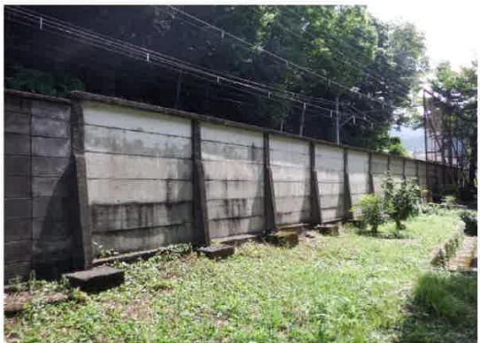
⑪ 敷地境界塀（北面）
