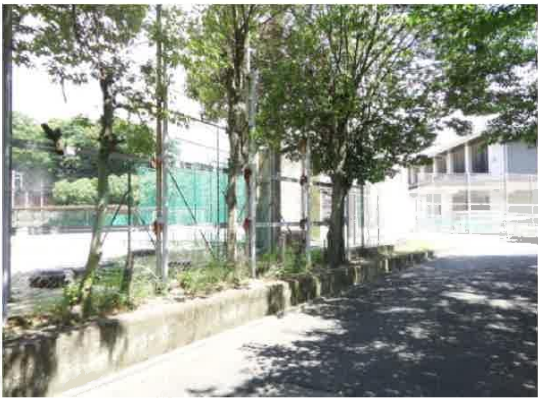
㉒ 敷地境界囲障（南側東面）
