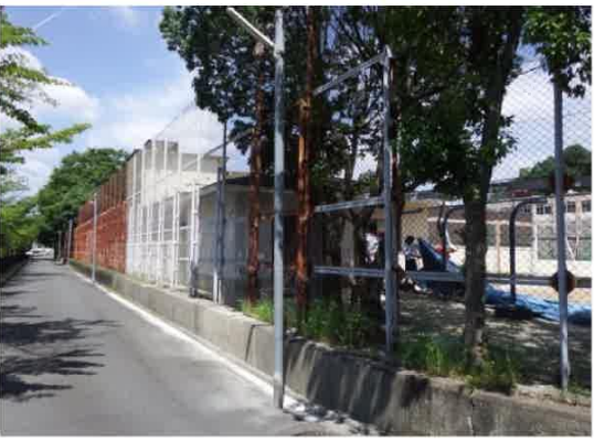
㉓ 敷地境界囲障（東側南面）
