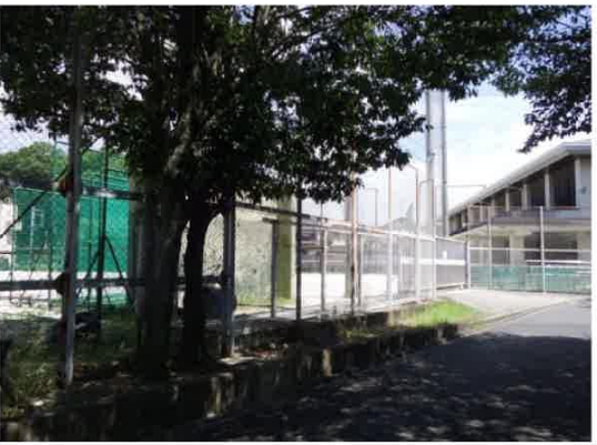
㉑ 敷地境界囲障（東面）
