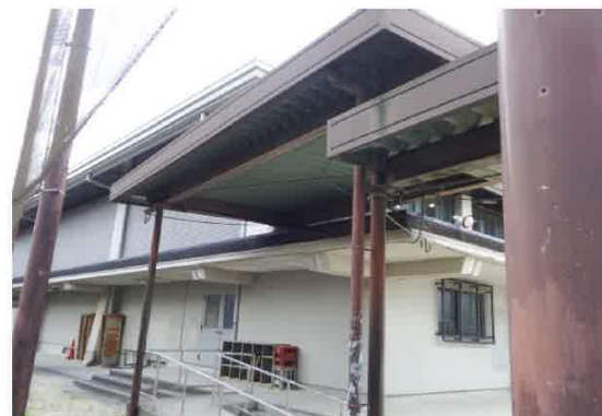
⑫ 渡り廊下1—北面（体育館接続部）
