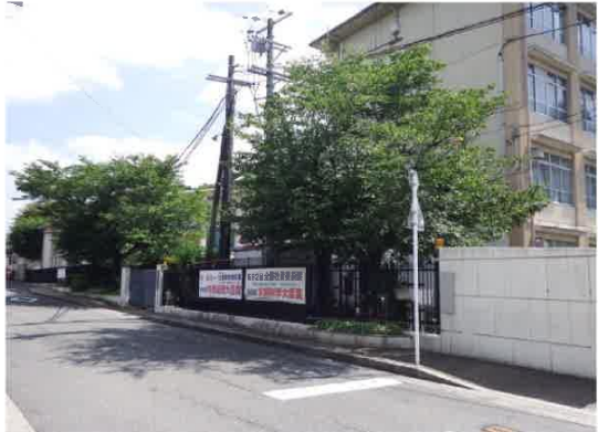
② 道路境界囲障（西側）
