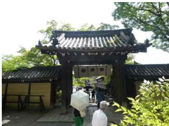
修理・修景前
