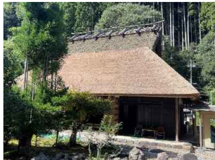
市指定文化財・日下部(式部)家 修理後
