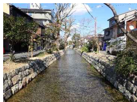
整備後 (六軒橋下流)
