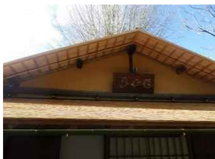
修理後 (屋根修理)
