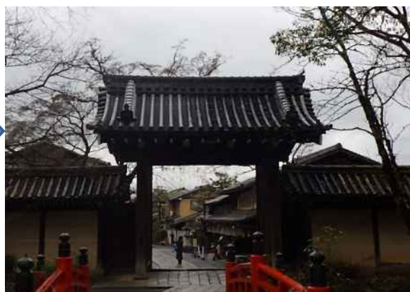
修理・修景後
