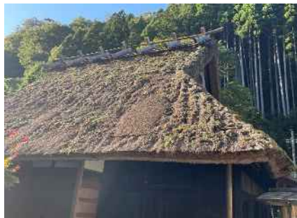
市指定文化財・日下部(式部)家 修理前
