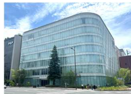
元ワコール新京都ビル 飛島建設
