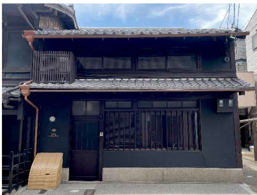
京町家の改修
