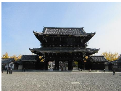
1-4 御影堂東側から御影堂門への眺望 ：周囲の建築物は植栽により見えない。
