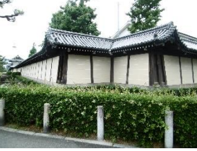
玄関門北側築地塀
