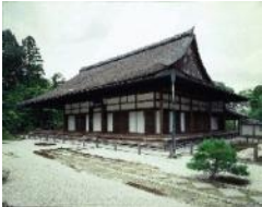
天授庵客殿 （附 玄関1棟・棟札1枚）及び表門
