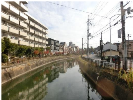
2-5 九条通の高架下から南への眺望 ：鴨川運河沿いには住宅が並ぶ。
