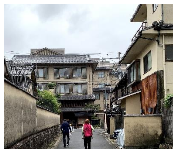
1-5 南側道路から南への眺望 ：八坂通沿いの建築物が見える。
