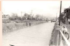
暗渠化前の疏水
