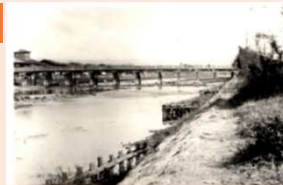
架け替え前の松原橋
