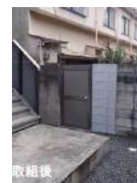
古いブロック塀 をつくり替え
