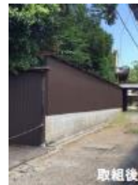
緊急避難 扉の設置
