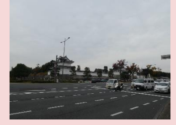
堀川通から見る二条城
