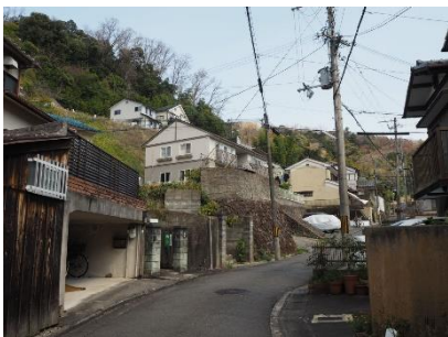
2-3 北白川仕伏町への町並み ：勾配地に住宅が立ち並んでおり、石積、擁壁が多い。
