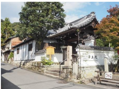
2-2 視点場の北側への眺望 ：視点場の北側に隣接する浄土院が建つ。
