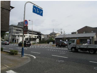
2-5 国道1号線から五重塔への眺望 ：離れたところからも五重塔が見える。
