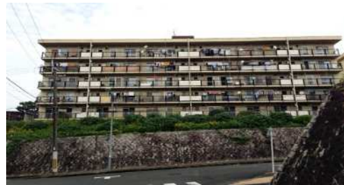
醍醐中山市営住宅 外観
