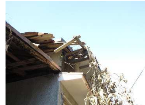
屋根部分 (東側から撮影)
