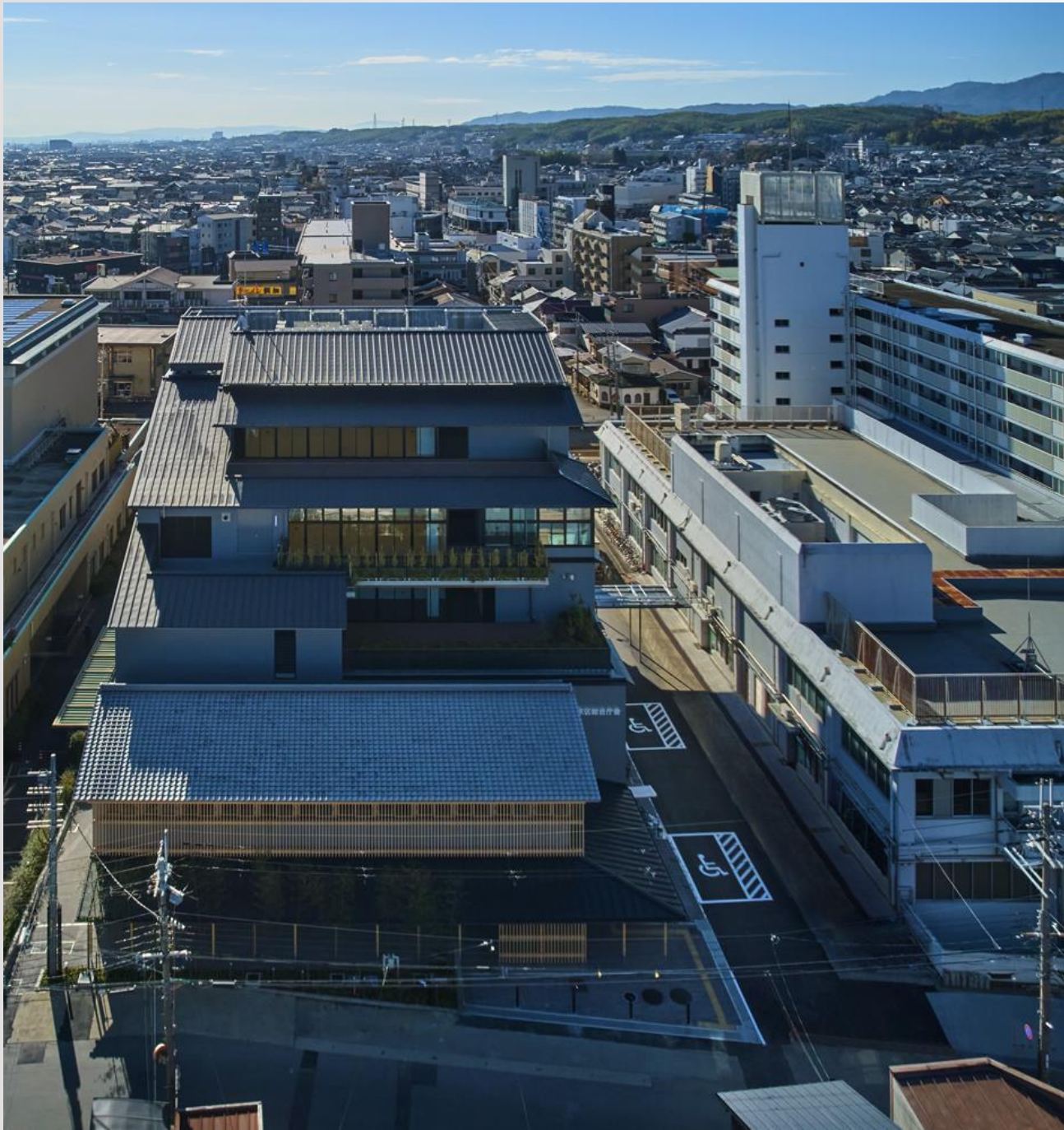
▲北側からの鳥瞰（西側（写真右）が西庁舎）
