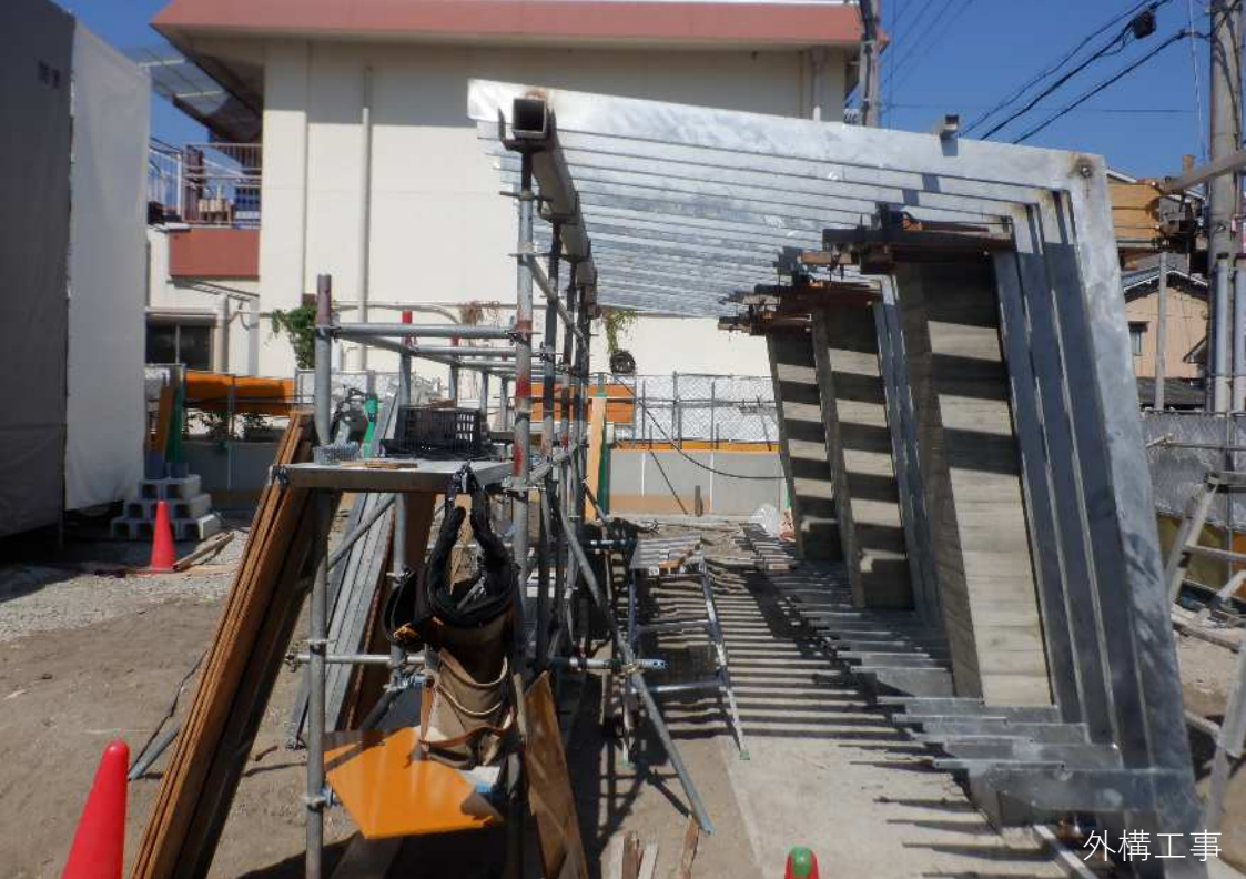
外構工事 外構工事
