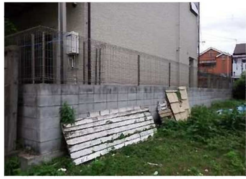
⑬ 敷地境界囲障（北側西面）
