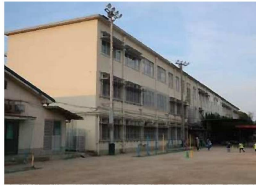
① ①北校舎棟一南面
