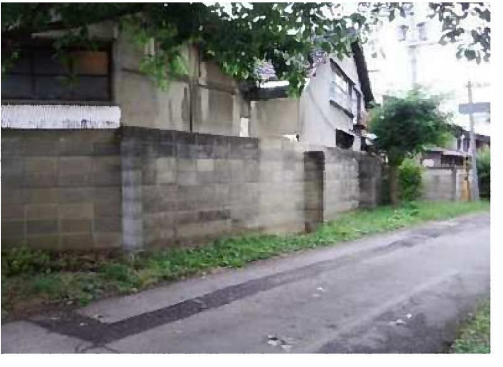
⑮ 敷地境界塀（北側）
