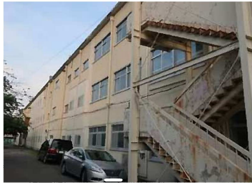
② ①北校舎棟一北面
