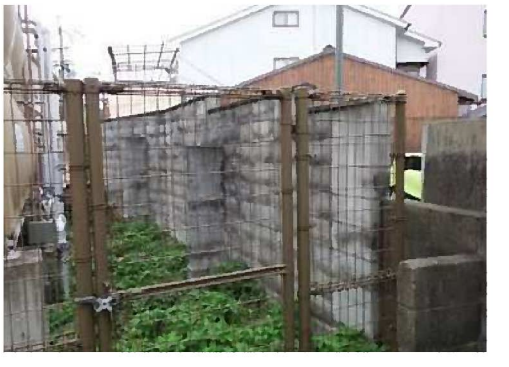
⑭ 敷地境界塀（北側東面）
