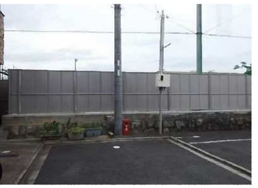
⑦ 敷地境界囲障（南側）
