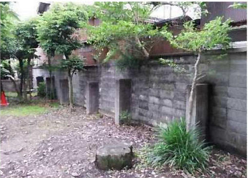
⑥ 敷地境界囲障（南側西面）
