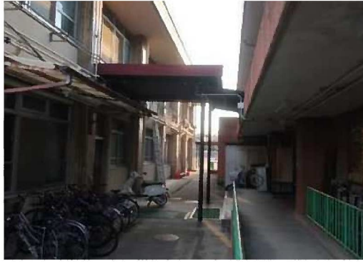
⑦ 渡り廊下4
