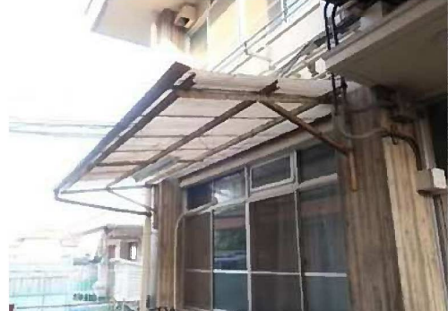
⑮ 上屋－2（本館北東側）
