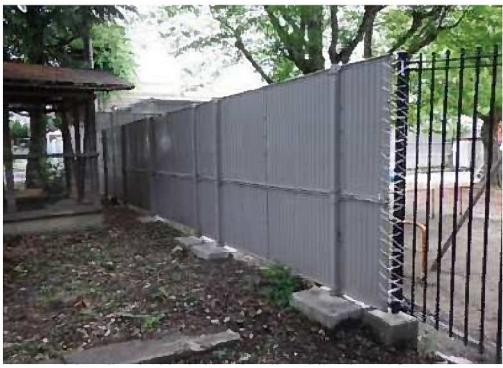
④ 敷地境界囲障（東側）
