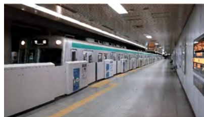
図 3-67 可動式ホーム柵 (地下鉄 烏丸御池駅)
