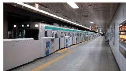
図 3-67 可動式ホーム柵 (地下鉄 烏丸御池駅)
