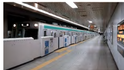
図 3-67 可動式ホーム柵 (地下鉄 烏丸御池駅)
