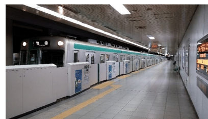
図 3-67 可動式ホーム柵（地下鉄 烏丸御池駅）
