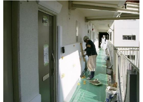
（断熱材の貼付工事の様子）
