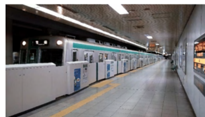
図 3-67 可動式ホーム柵（地下鉄 烏丸御池駅）
