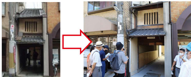
トンネル路地の耐震・防火改修工事 路地の入口がトンネル状になっているところでは、地震で崩れると逃げられません。耐震補強し、唯一の避難路の安全性を高まりました。
