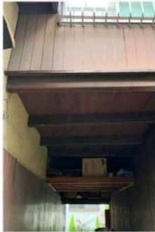
トンネル部分を補強した例(栗田学区内)
