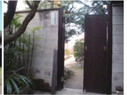
路地に設置された避難扉例(※)
