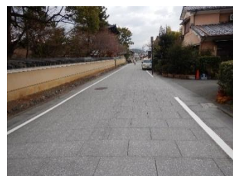
石畳風アスファルト舗装後
