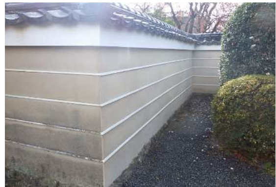
修理・修景後
