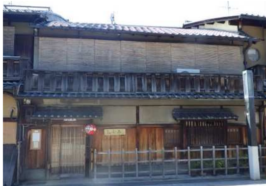
修理・修景前
