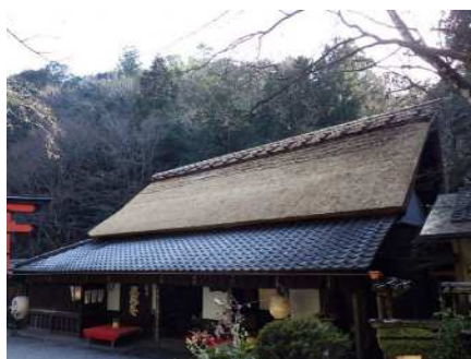
修理後 (屋根修理)
