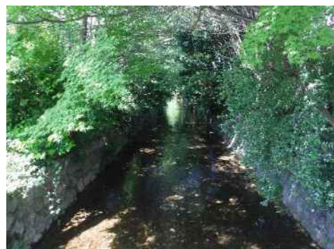
整備前 (六軒橋下流)
