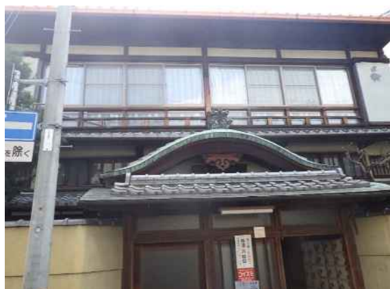
修理・修景前
