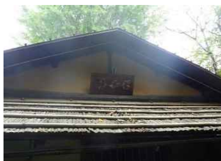
修理前 (屋根修理)
