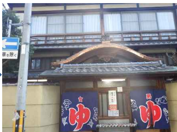
修理・修景後
