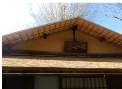
修理後 (屋根修理)
