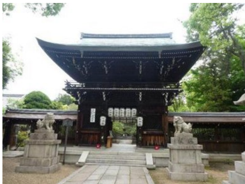
修理前 (屋根修理)
