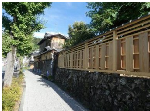
修景後 (板塀修景)
