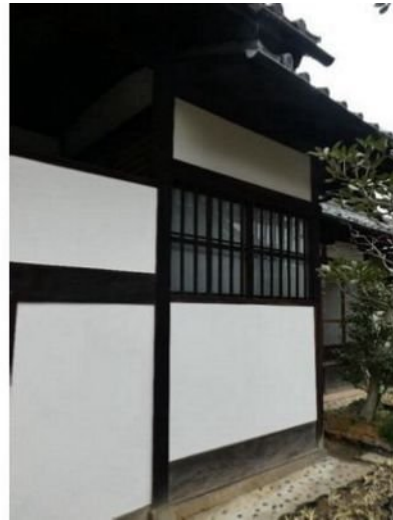
修理後 (外壁塗替え)
