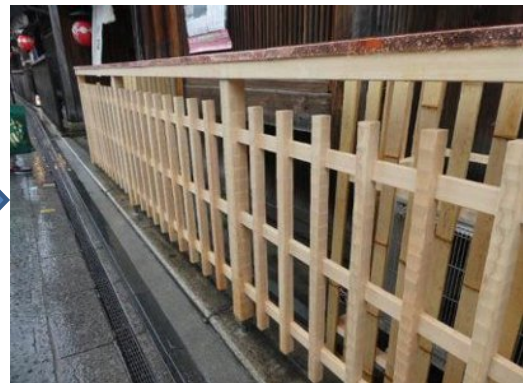
修景後 (犬矢来→駒寄改修)
