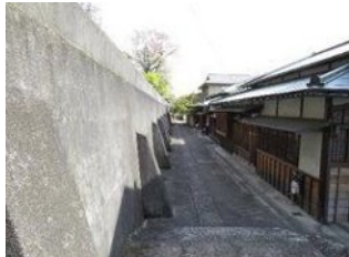
吉田神楽岡旧谷川住宅群 改修前
