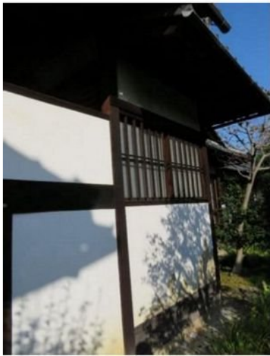
修理前 (外壁塗替え)
