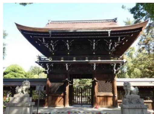
修理後 (屋根修理)
