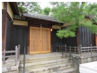
修景後(塀等修景工事)
