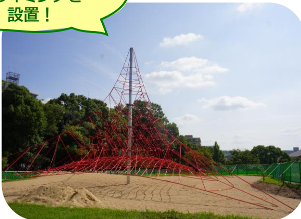
境谷公園 遊具 (工事施工中)
