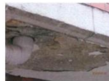
バルコニー裏に欠損が見られる
