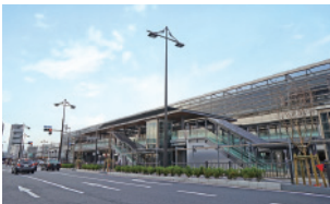
▲新しくなった京都駅八条口駅前広場
