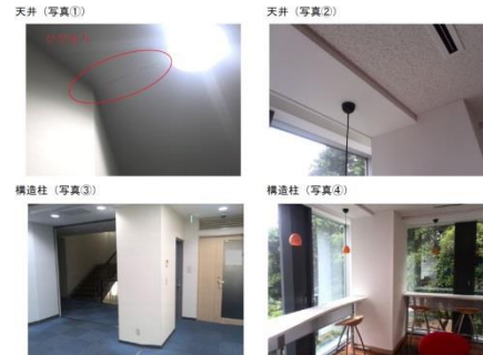
《安全点検箇所の平時写真撮影（例）》
