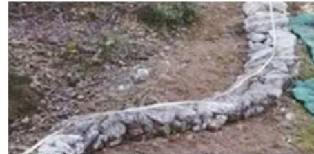
石を詰めたネットを斜面に設置し，土の流れを抑制した例
